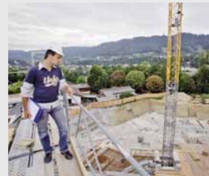
Überblick über die Baustelle In luftiger Höhe lässt sich der Fortschritt der Bauarbeiten besonders gut überprüfen.
