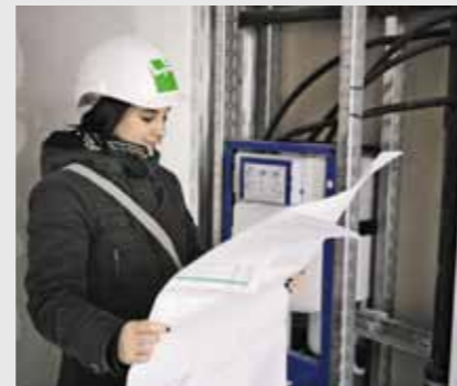
Kontrolle des Arbeitsfortschrittes Gebäudetechnikplaner/innen kontrollieren auf der Baustelle den Arbeitsfortschritt anhand eines selbstständig erstellten Planes.
