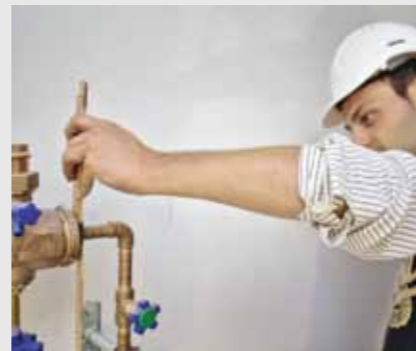
Masskontrolle Die Überprüfung der korrekt installierten Geräte – zum Beispiel eines Kaltwasserverteilers – gehört ebenfalls zum Aufgabengebiet der Berufsleute.
